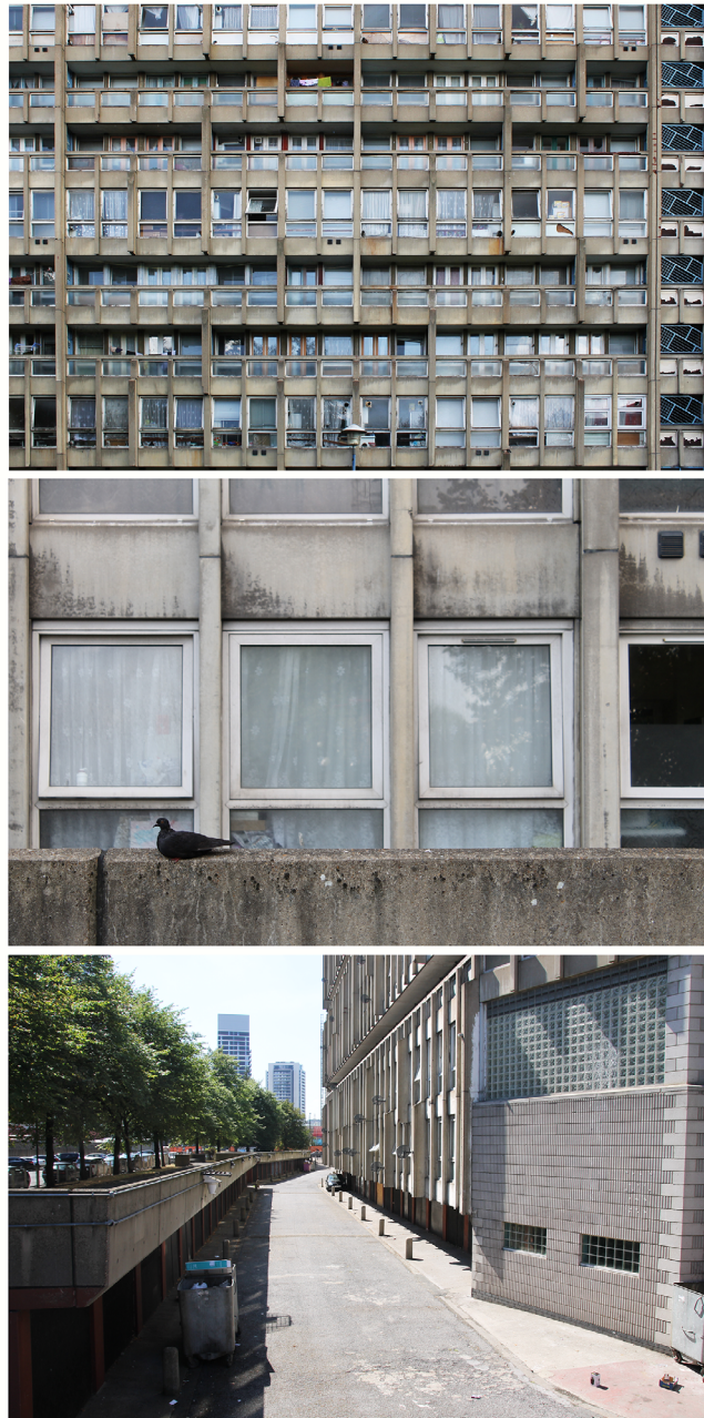
Imagen 1. Estado del conjunto Robin Hood Gardens previo a las obras de demolición (fuente: Del autor, 2017).
