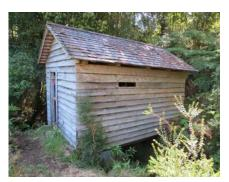
Imagen 6. Molino chilote suspendido en troncos enterrados. El entablado de los muros deja solo unas cuantas ranuras a modo de iluminación, evitando que el viento se lleve la harina. Las tejuelas de alerce constituyen un rasgo marcadamente chilote (José Bravo 2014).
