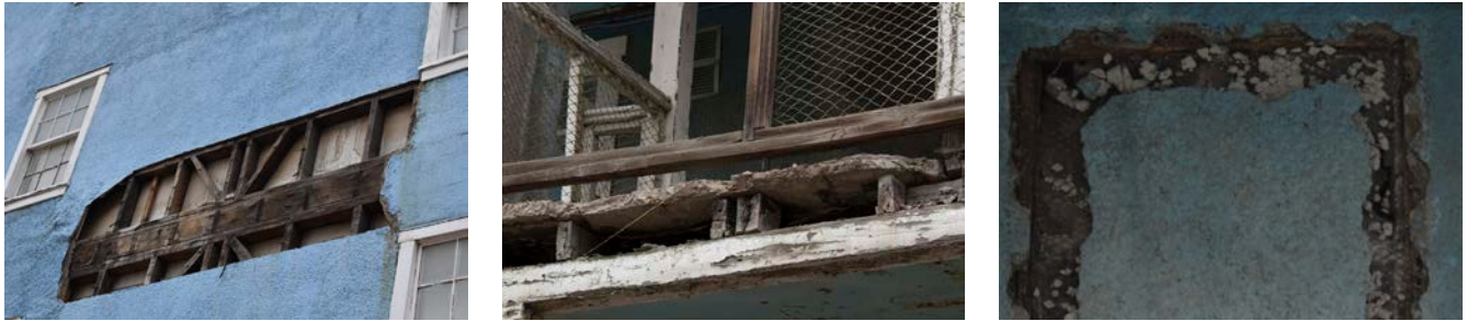
Imagen 3. (a) Estructura paramentos verticales, (b) radier y (c) recubrimiento envolvente (fuente: Las autoras, 2019).
