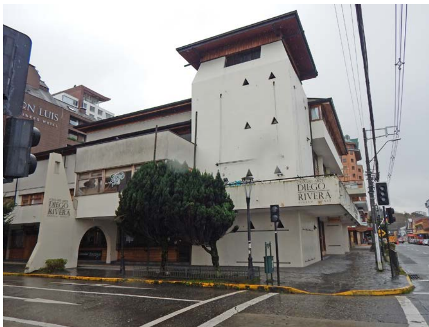
Imagen 4. La esquina con la torre de la Casa del Arte Diego Rivera (fuente: fotografía de Gonzalo Cerda Brintrup).
