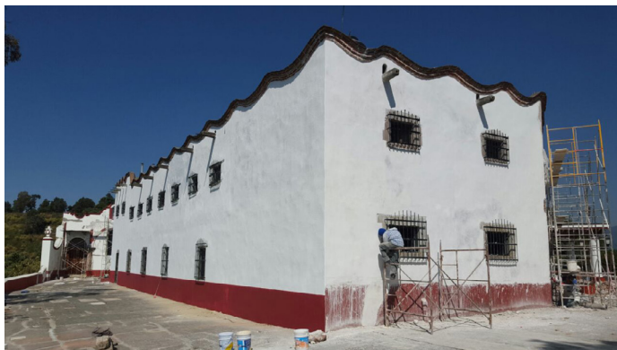
Imagen 11. Proceso de restauración del claustro del Santuario (fuente: Cortesía de Eder Torres Villamar del Consejo Parroquial, 2018).
