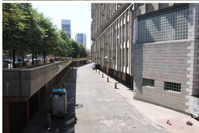
Imagen 1. Estado del conjunto Robin Hood Gardens previo a las obras de demolición (fuente: Del autor, 2017).
