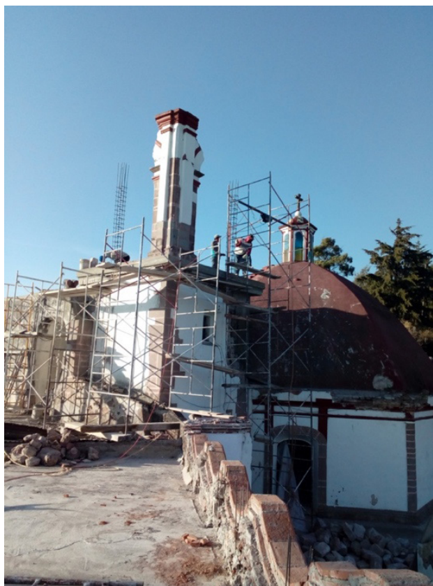
Imagen 9. Trabajadores contratados por la comunidad en la torre (fuente: Cortesía de Eder Torres Villamar del Consejo Parroquial, 2017).
