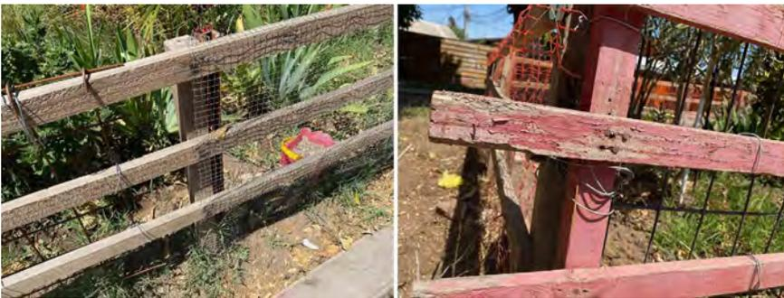
Imagen 17. Conexión entre los pilares y las mallas mediante alambres y grapas (fuente: Del autor,2022).
